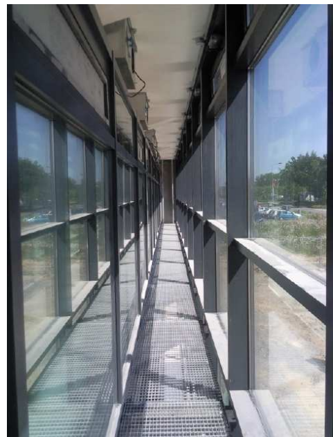
Les façades nord et sud du bâtiment sont équipées de parois vitrées double peau.
