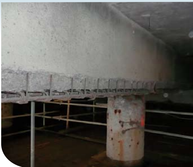
chantier pilote : poutre avant et après réparation en projection par voie humide.
