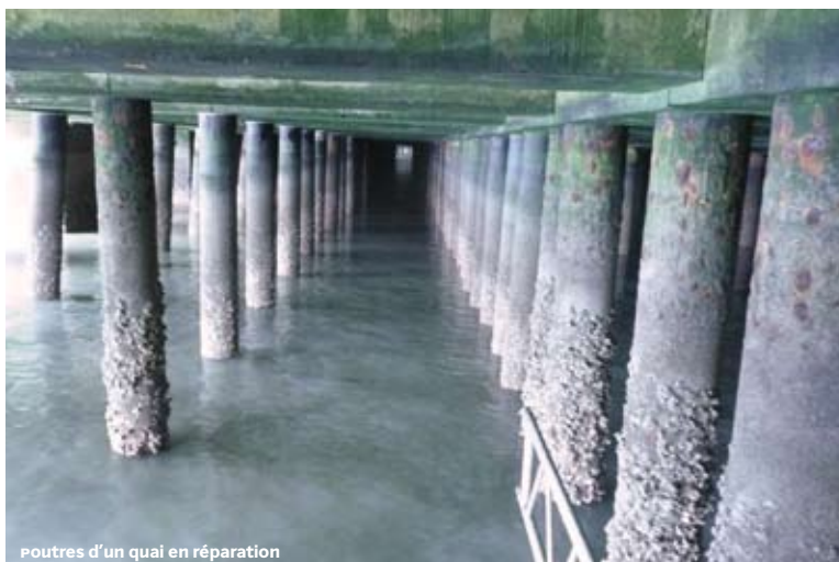
poutres d'un quai en réparation
