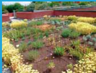
Toitures végétalisées, Antibes 107
