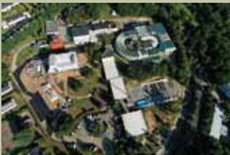
Aquasim, Nantes 1/11 Equipement du CSTB qui simule grandeur nature les processus de collecte et de production des eaux. © DR
