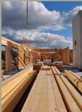
Chantier de construction bois, Nantes 100 Établissement de Santé pour Enfants et Adolescents de Nantes (ESEAN) © ATLANBOIS, Carole Humeau
